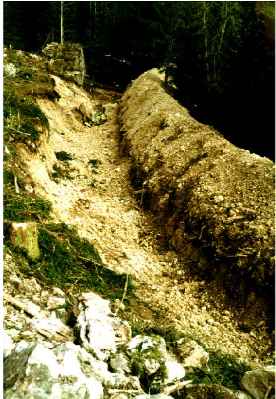
**Abb. 24 Schutzgraben und –wall von Westen aus. Aufnahme des Autors.**
